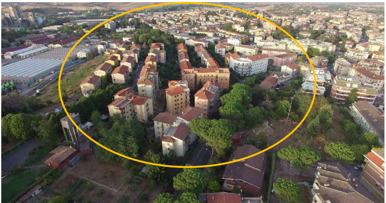
Vista attuale del quartiere di S. Barbara
