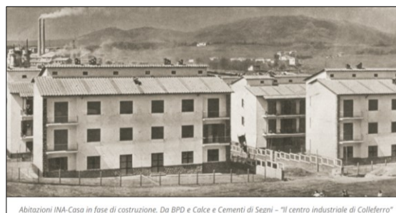
Abitazioni INA-Casa in fase di costruzione. Da BPD e Calce e Cementi di Segni - "Il centro industriale di Colleferro"
