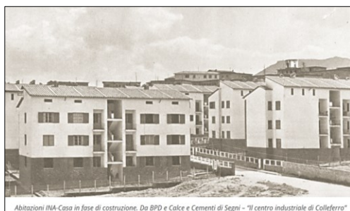
Abitazioni INA-Casa in fase di costruzione. Da BPD e Calce e Cementi di Segni - "Il centro industriale di Colleferro"
